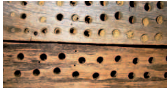
Angebohrtes Holz – die ersten Gänge sind bereits von Bienen belegt.
